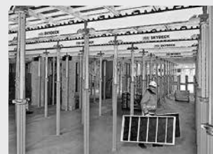
Stropní bednění
