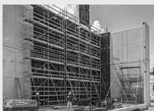
Pracovní lešení na staveništích
